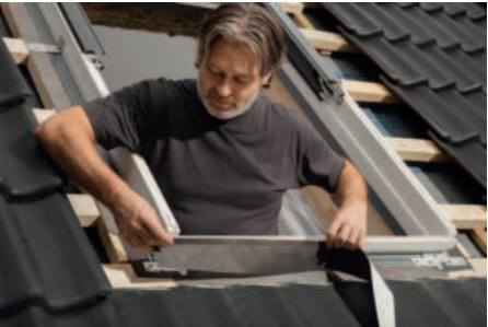
1. Fenster an den Seiten mit dem Klebeband abdichten
