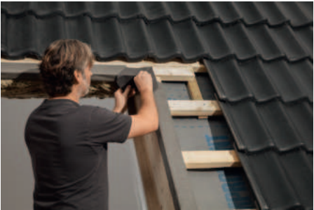
2. Fensterecken mit den vorgefertigten Anschlusssecken abdichten
